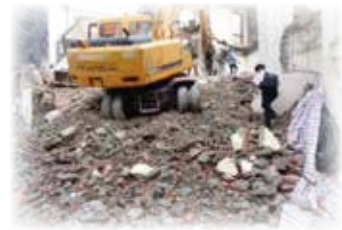
解体現場での排出量調査
