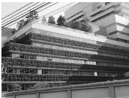
植生基盤と補助資材のユニットによる壁面緑化 (千代田区 二番町ガーデン)
