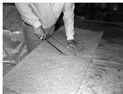
網状マットの切断状況
