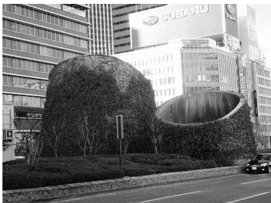
補助資材を利用した壁面緑化 (新宿駅西口広場吸排気塔)
