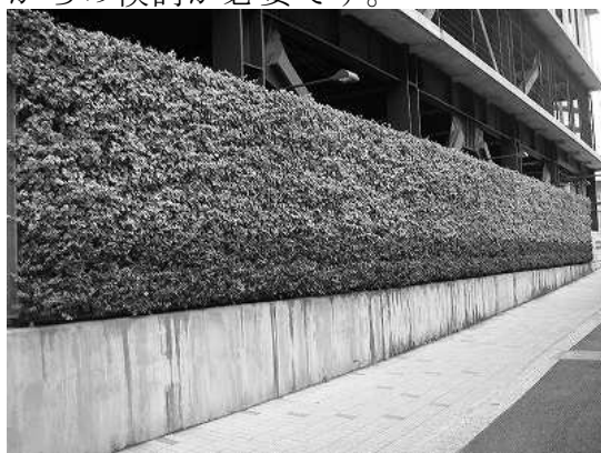
ヘデラを用いた基盤造成型の壁面緑化 (横浜そごう駐車場)
