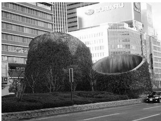
補助資材を利用した壁面緑化 (新宿駅西口広場吸排気塔)
