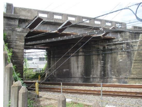
橋りょう架換え工事 国道463号（建武橋）
