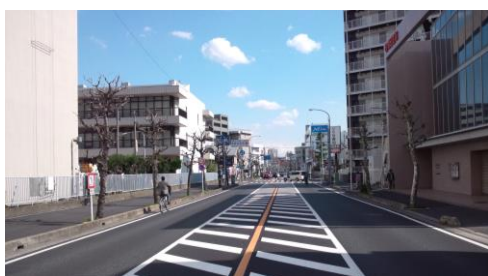
無電柱化の実施状況（県道川口上尾線）
