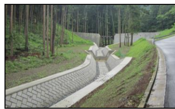
溪流保全工／割谷川
