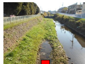
堆積した土砂の撤去
