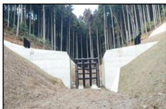
砂防堰堤工／慈光寺川
