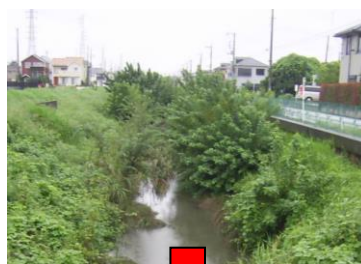
河道内樹木の伐採
