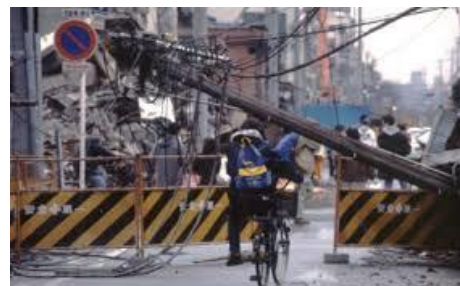
阪神淡路大震災での電柱倒壊
