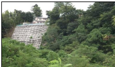
急傾斜地崩壊対策工／近戸上地区
