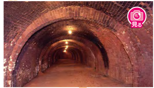
昭和43(1968)年の操業停止まで、多くの煉瓦を焼いてきたホフマン輪窯
