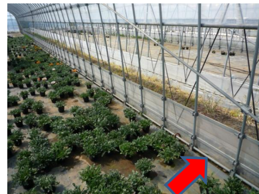
③沈下防止用パイプ
