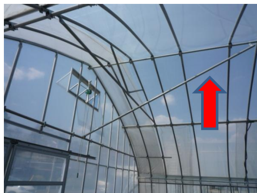
④妻面と棟を直管で斜めに梁
