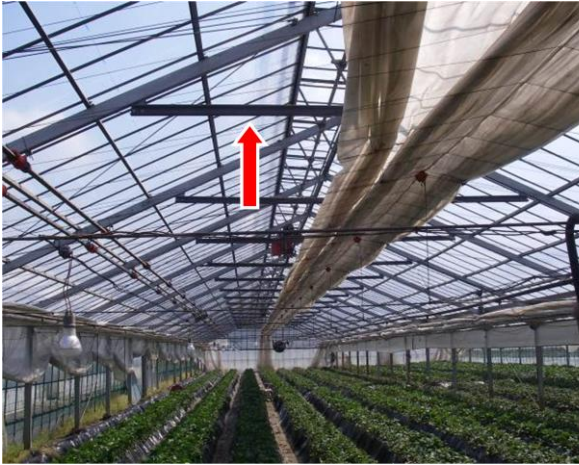
屋根材の補強：L鋼材タイバー
