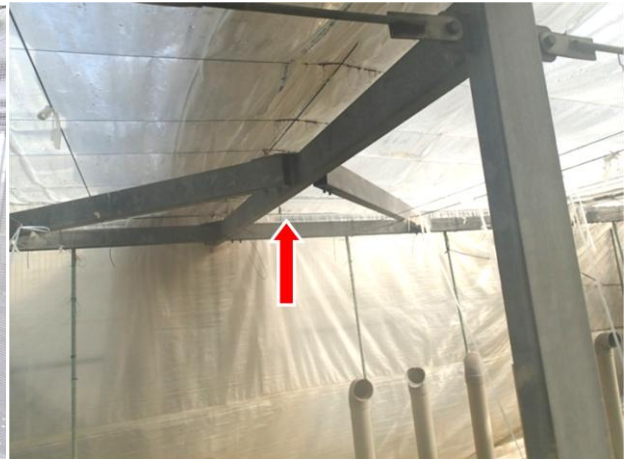
梁と柱の補強（角パイプ）
