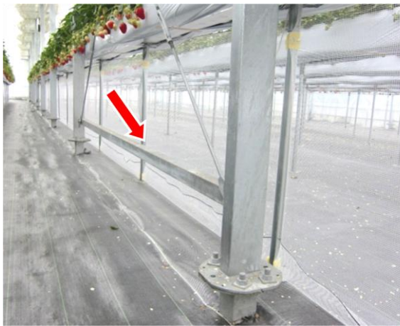
柱と柱の補強（角パイプ）
