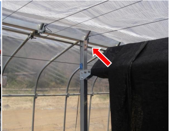
柱と梁を補強
