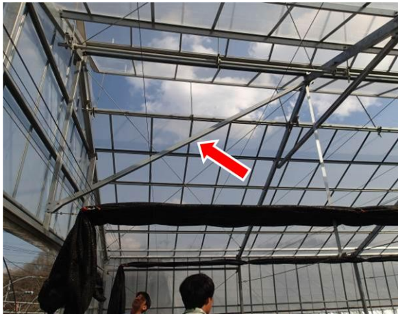
妻面と屋根の補強（角パイプ）
