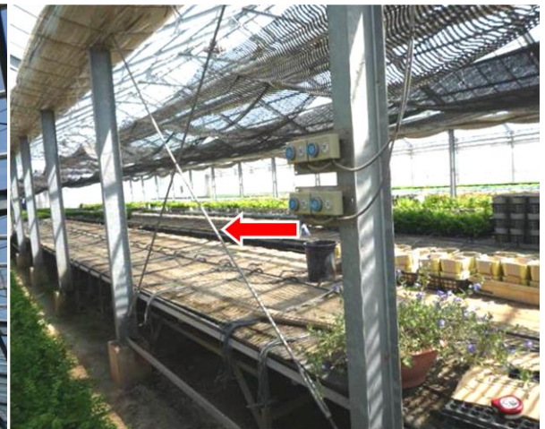
柱材の補強：X状に設置
