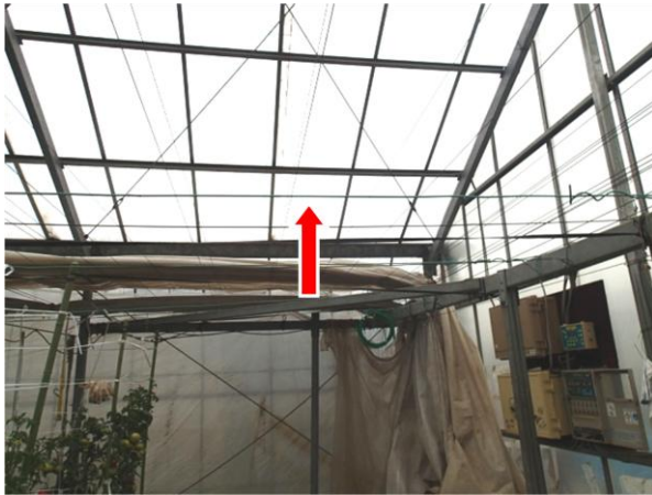
妻面に設置（ワイヤー）
