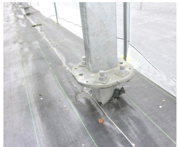
鉄柱基礎（鉄柱打込み：約1m）
