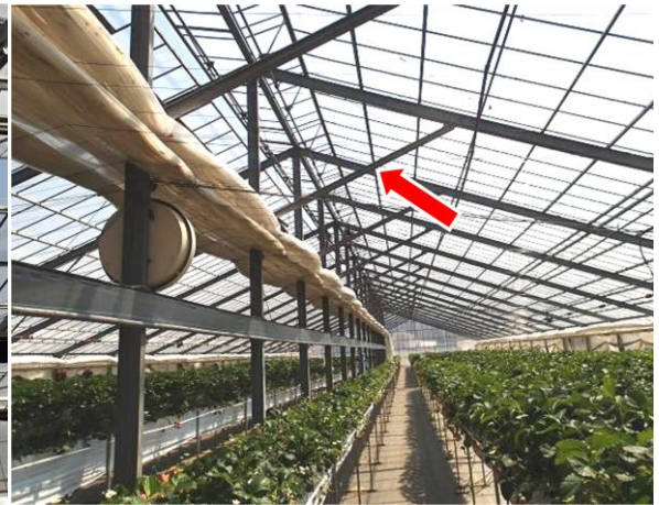
屋根と柱の補強（角パイプ）
