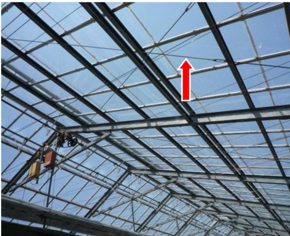
屋根材の補強：X字状に設置
