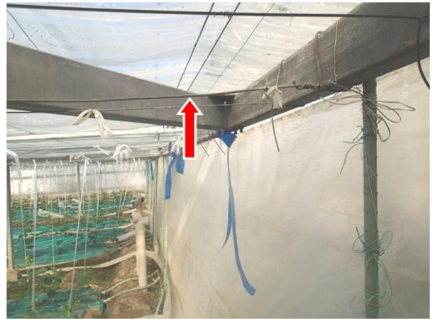
梁材に設置（ワイヤー）
