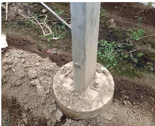
セメントの容積、接地面が大きい
