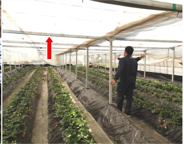
柱材の補強：角パイプ鋼材陸梁
