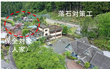
砂防関係施設整備
