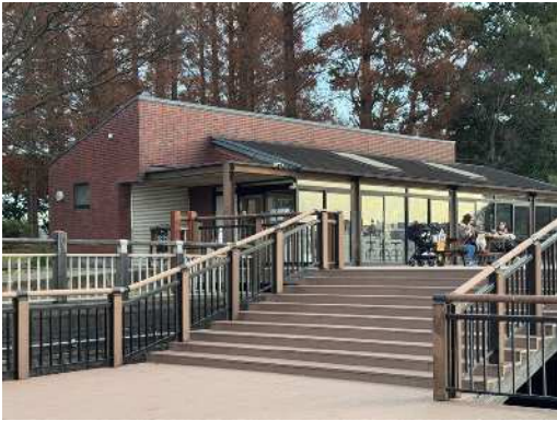
【カフェ・ウッドデッキ】
