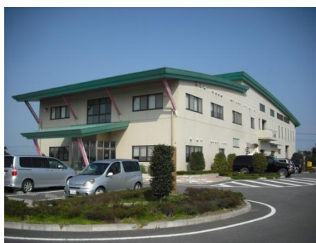
汚泥再生処理センター全景
