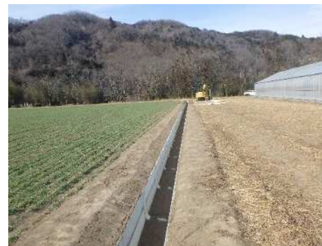
排水路工実施後（令和7年2月末時点）
