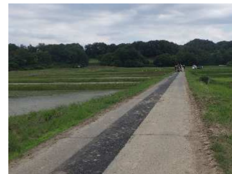
幹線パイプライン実施状況
