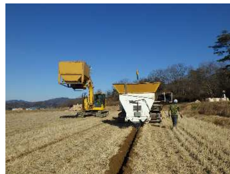
暗渠排水工実施状況
