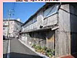
空き家の除却
