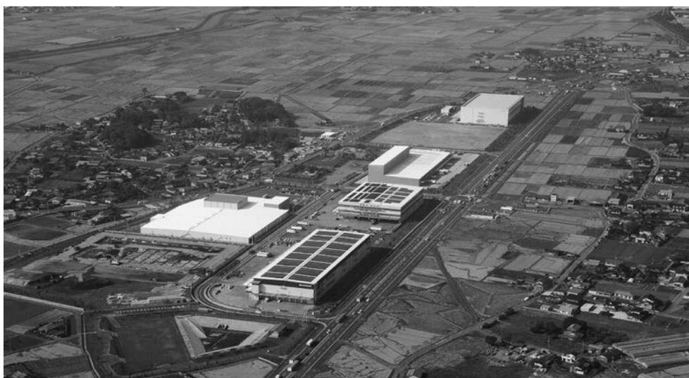
【主要幹線道路周辺での産業基盤づくり】 騎西城南産業団地（加須市）
