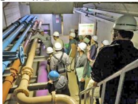
②処理場通路内
