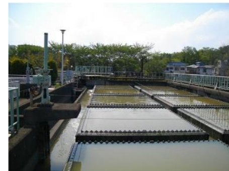
④最初沈殿池
