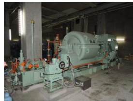
送風機（空気を吹き込む機械）
