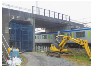
▲耐震補強補修工事中の東武野田線跨線橋(春日部市)
