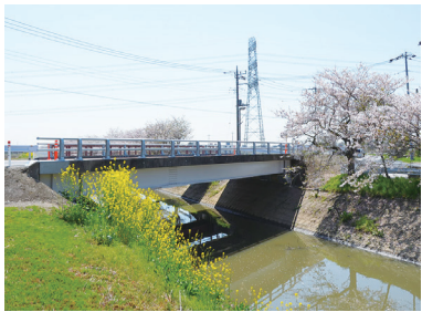
▲耐震補強補修工事後の鹿島橋(杉戸町)
