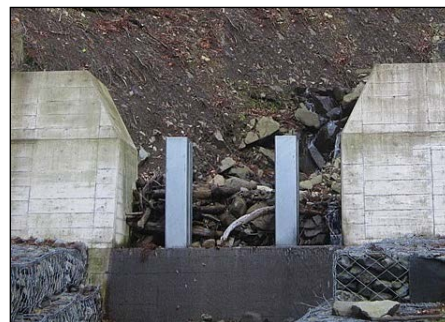
治山施設の設置
