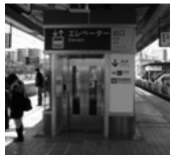
エレベーター(改札内)
