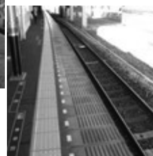
内方線付き点状ブロック
