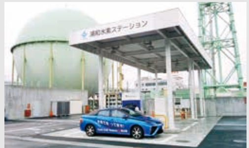
浦和水素ステーション
