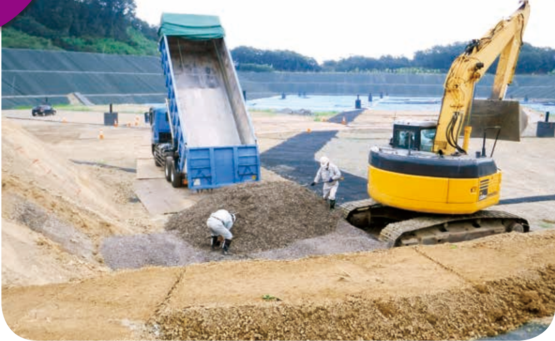
最終処分場での目視検査
