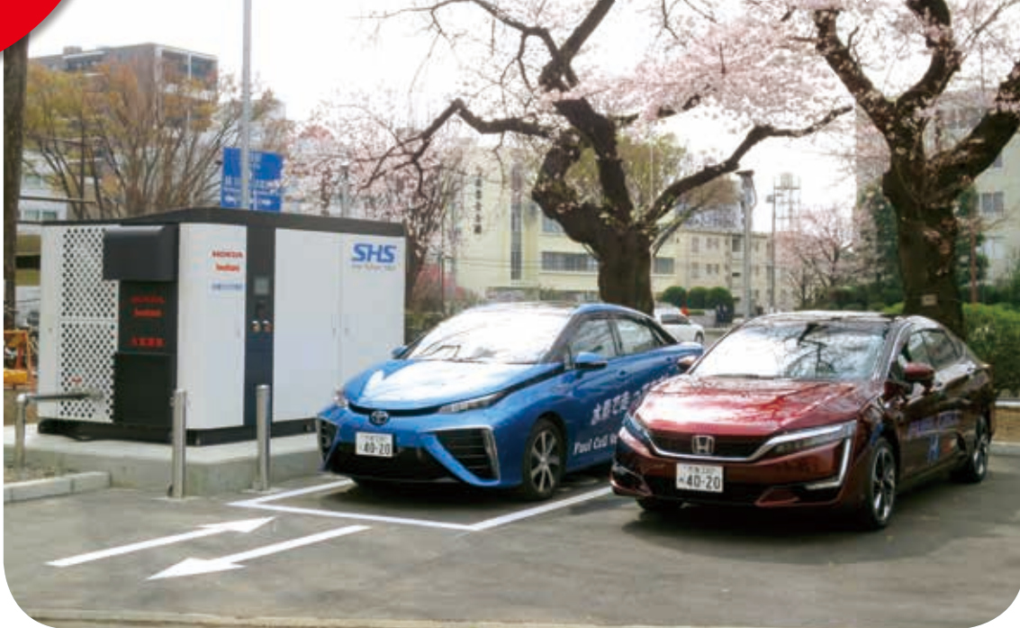
燃料電池自動車 (FCV) と県庁スマート水素ステーション
