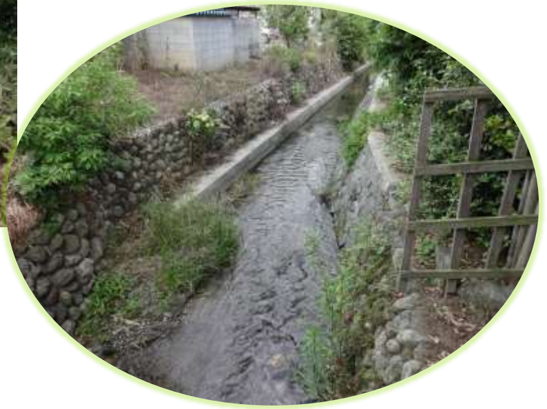
御陣場川起点から下流を望む
