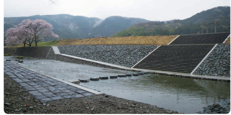
不動尊の滝周辺の拠点施設 (飛び石・階段護岸の整備)
