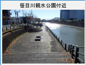
歩道 【根木橋～堤向橋 (新曽側)】
