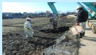
■ 大沼での工事の状況
