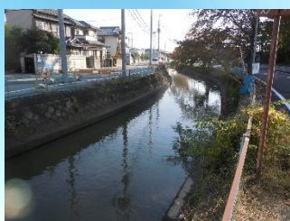
金兵衛橋付近 整備前
