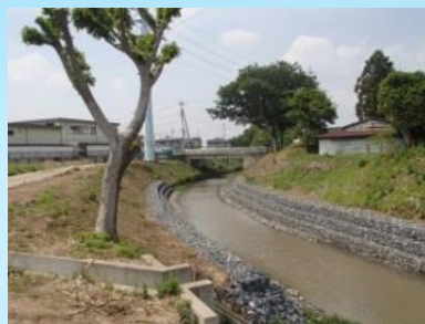
■ 環境護岸(最下流部)
