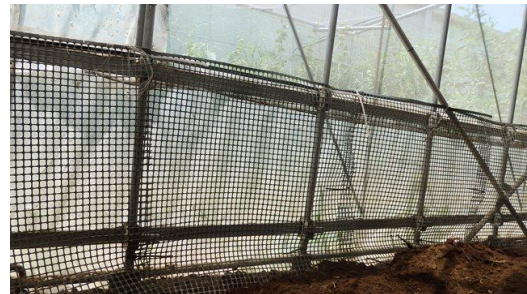
隙間風の防止 下部 50 cm をシートで被う
