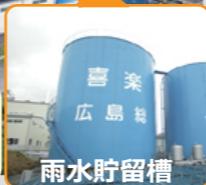
容量2,500m 3 の屋外貯留槽。このほか地下分離槽に約530m 3 を貯留。
