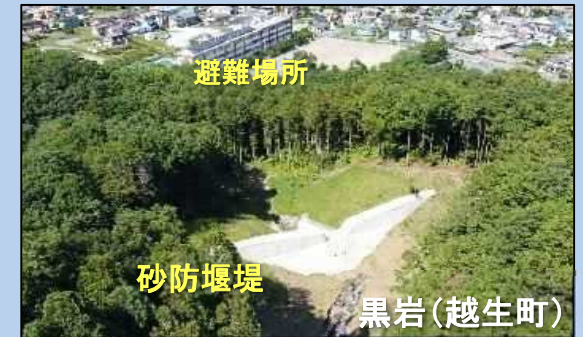
土砂災害防止施設の整備
