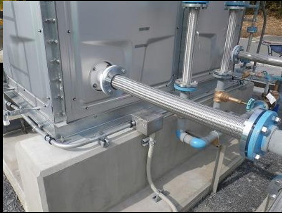
変位吸収継手（可とう継手）
