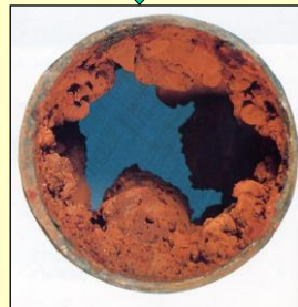
配管内の腐食診断
